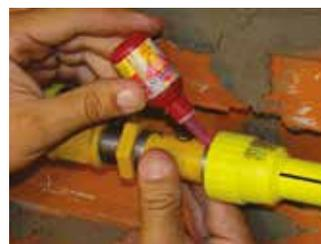
**5.** Colocando selladores aprobados, enroscar la conexión completa a la transición hembra, por el extremo de rosca más corto (el que no contiene cupla y tuerca).
