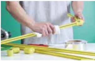
**1.** Antes de la colocación de la cinta de protección, la tubería debe encontrarse limpia y seca. Utilizar sólo cinta de aluminio SIGAS Thermofusión®, de máxima adherencia.
