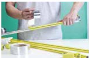
**3.** Una vez cubierto cada accesorio, la protección anti UV continuará con el resto de la tubería. A tal efecto, la cinta se aplicará en forma helicoidal sobre los tubos, tratando de
