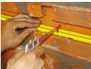
**2.** Cortar y sacar de la tubería existente un trozo del largo del conjunto ya armado, menos las penetraciones de esa tubería en el Te y en la transición macho.
