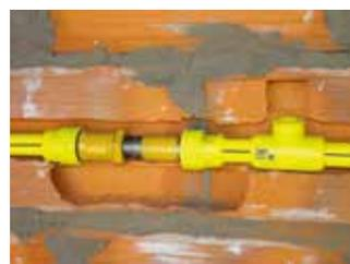
**8.** Una vez probados los trabajos de modificación, agregar a la conexión completa la protección anticorrosiva reglamentaria.
