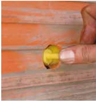
**6.** Completado el ciclo de calentamiento de doble etapa, se retira el Termofusor rápidamente y se coloca la montura ejerciendo presión suave sobre ella sin producir movimiento alguno por 30 segundos. El proceso de termofusión de la montura se completa con el proceso natural de enfriamiento.
