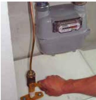
**1.** Si la tubería está bajo carga hay que cortar el suministro de gas a la vivienda, cerrando la llave de paso de entrada al edificio. Previamente hay que asegurarse de que todos los artefactos estén apagados.
