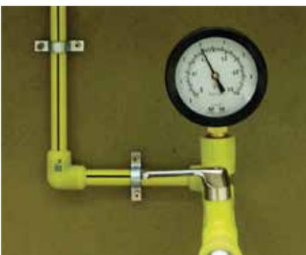
Conforme a lo estipulado en el punto 3.3 de las DISPOSICIONES Y NORMAS MÍNIMAS PARA LA EJECUCIÓN DE INSTALACIONES DOMICILIARIAS DE GAS VIGENTE, la instalación de baja presión soportará, sin pérdidas, una presión neumática manométrica de 0,2 Kg./cm<sup>2</sup> (0,0196 MPa).
