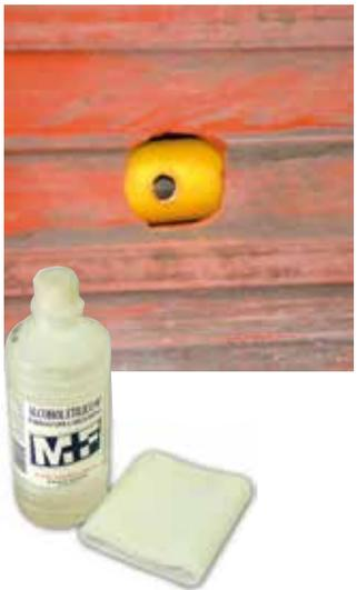
**2.** Descubierta la zona afectada, la misma debe limpiarse con cuidado, asegurando toda eliminación de polvo, grasitud, humedad o agua, con papel tissue o paño limpio, seco y de material no sintético, humedecido en alcohol fino. El mismo proceso debe seguirse con la montura de reparación. Si fuera necesario pasar una lija fina para retirar todo tipo de impurezas en la superficie a calentar.
