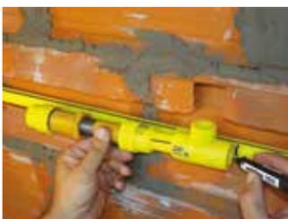
**1.** Armar fuera de la canaleta el conjunto: Te + transición hembra + conexión completa. El Te y la transición hembra se unen fusionando entre ambos un trozo de tubo del largo deseado.
