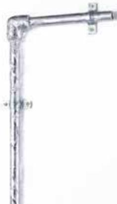
**5.** Los puntos donde la tubería se encuentre empotrada mediante grapas metálicas, deberán llevar dos vueltas adicionales de cinta aislante para brindarle al recubrimiento una mayor resistencia mecánica. Estas vueltas adicionales se instalarán en forma perpendicular al eje de la tubería.
