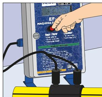
**5.** Durante la electrofundición y la consiguiente etapa de enfriamiento, evitar movimientos y tracciones sobre el ensamble por espacio de 10 minutos.
