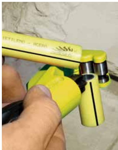
Corte con corta-tubo en obra.
