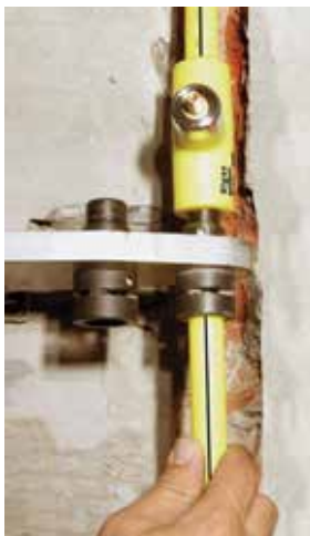
Thermofusión en la canaleta.
